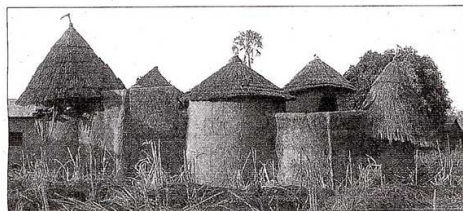
Les tata somba sont des petites forteresses en torchis avec des toits de paille, typique de la région de Koussoukoingou.
